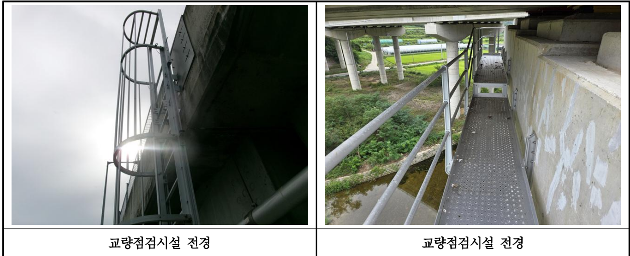
【사진 16.3.26】 교량 점검시설 전경
