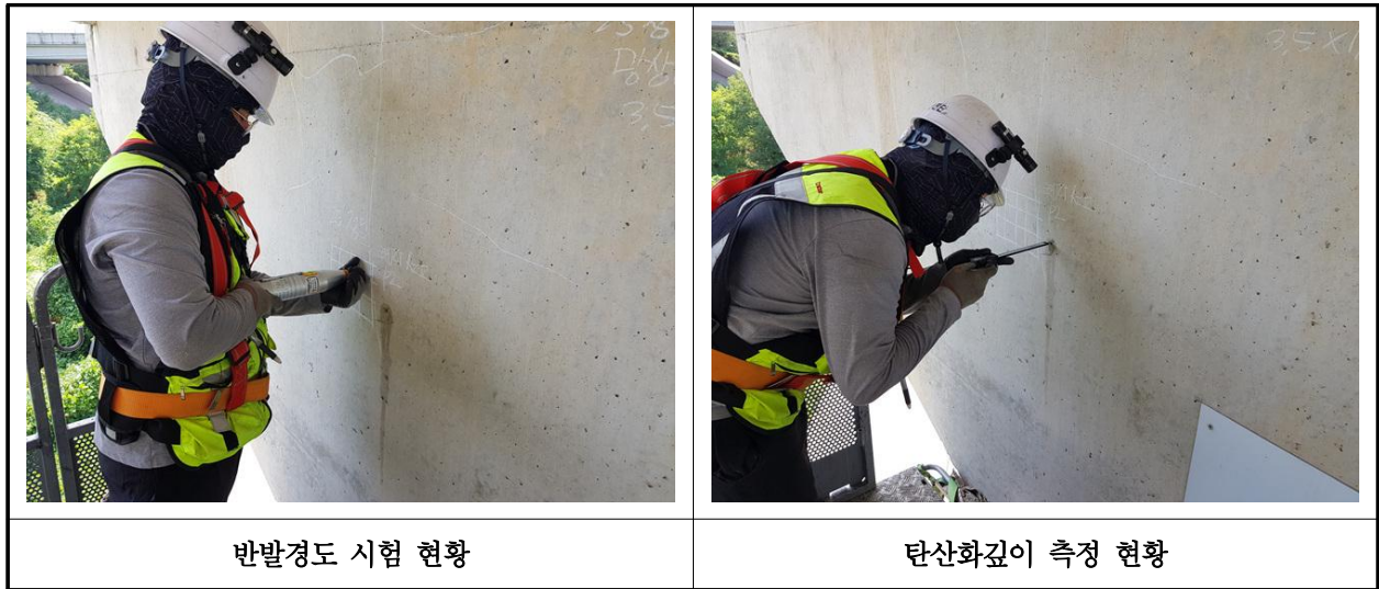
【사진 16.4.1】 콘크리트 내구성조사 현황
