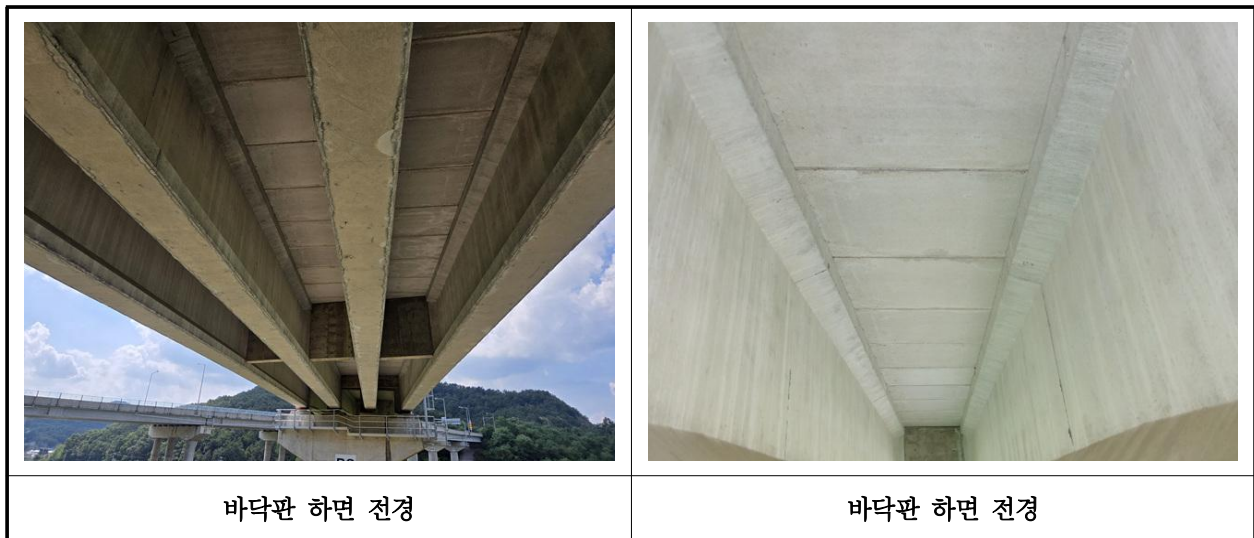
【사진 16.3.2】바닥판하면 전경
