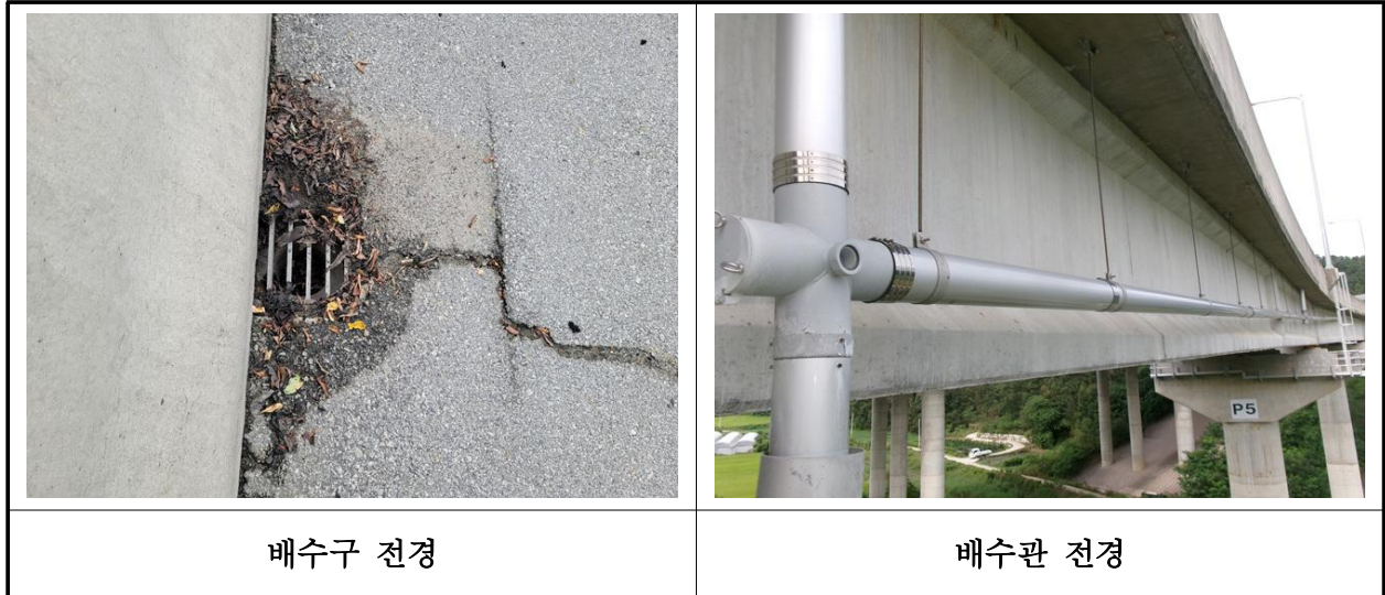
【사진 16.3.22】 배수시설 전경
