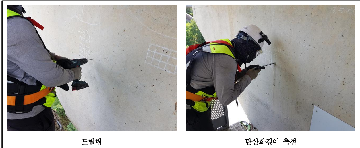
【사진 16.4.3】 탄산화 깊이 측정 현장사진
