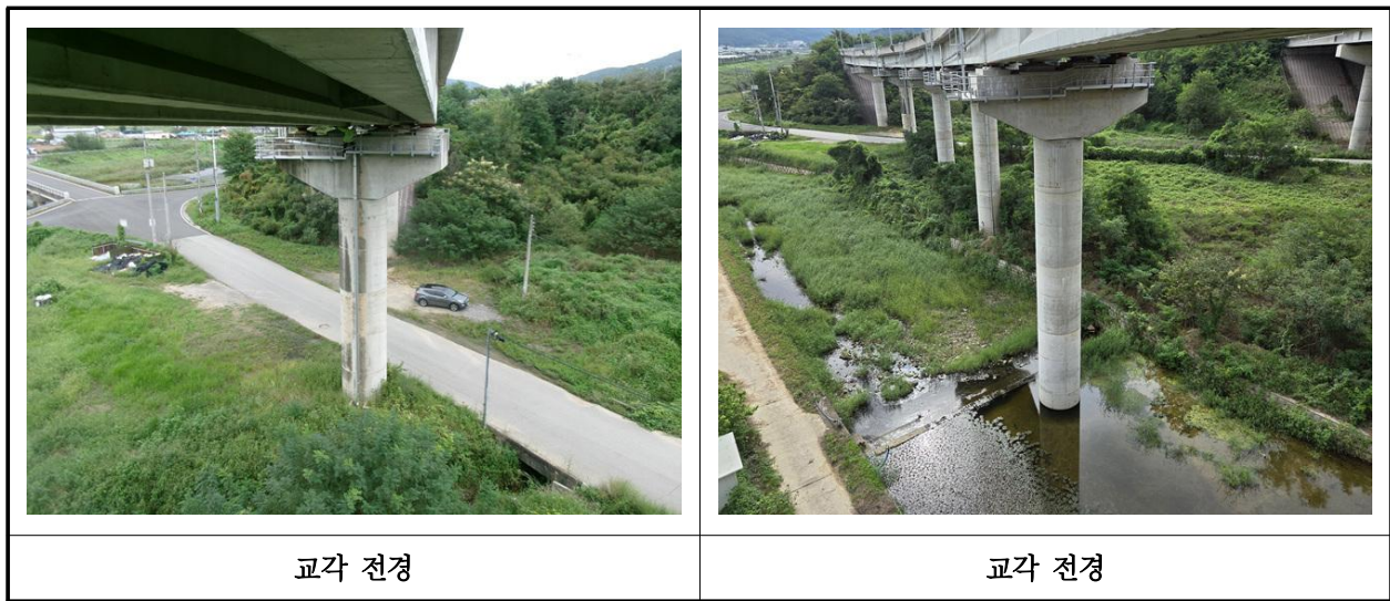
【사진 16.3.10】 교각 전경
