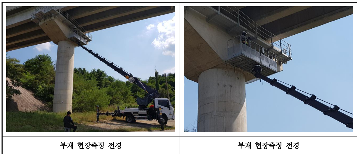
【사진 16.2.1】 부재 현장측정 전경
